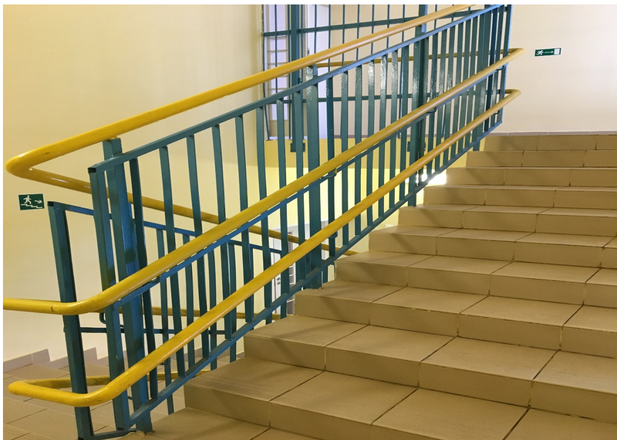
Фото № 32. Лестница внутри здания
