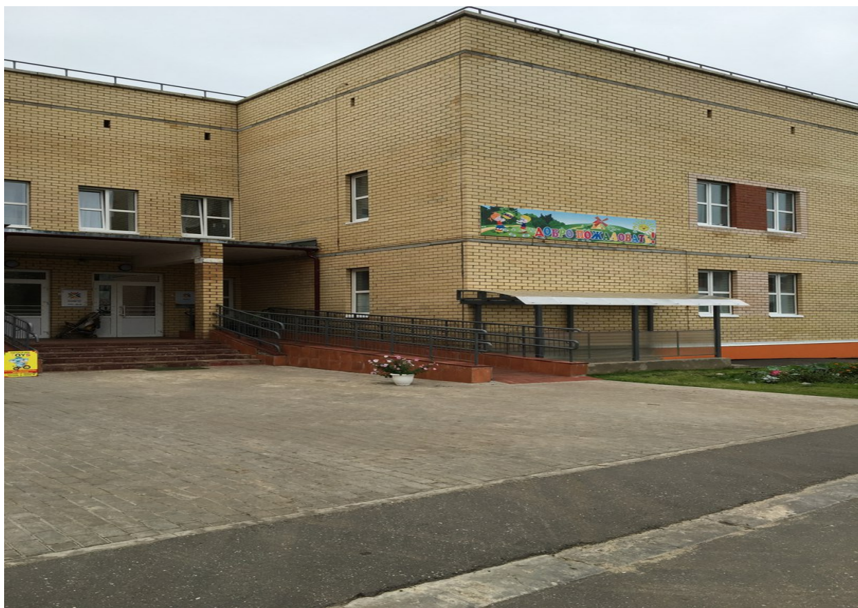
Фото №21. Вход №5 пандус.
