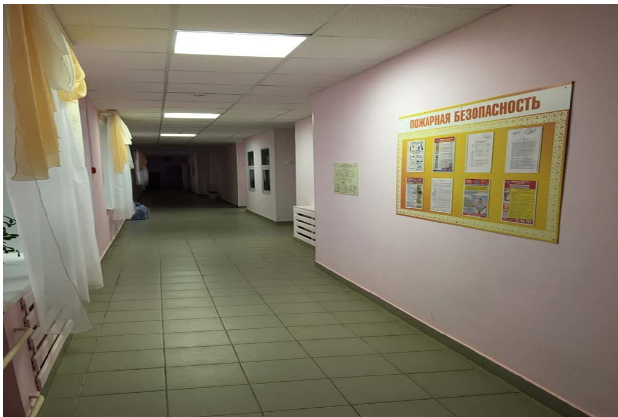
Фото 29. Коридор пути движения внутри здания
