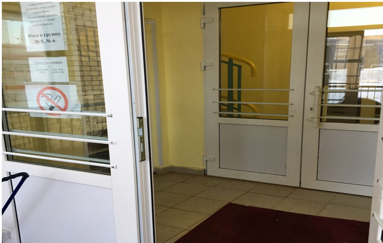
Фото №20. Вход №5 тамбур.
