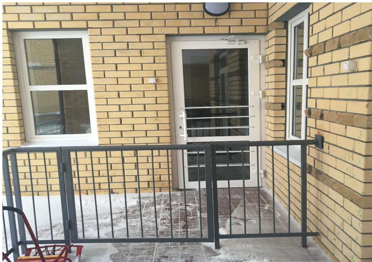
Фото № 16 Вход № 4 (пищеблок)
