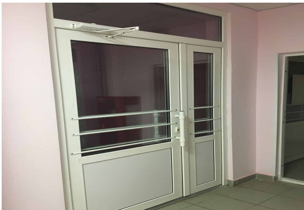
Фото №11 Центральный тамбур
