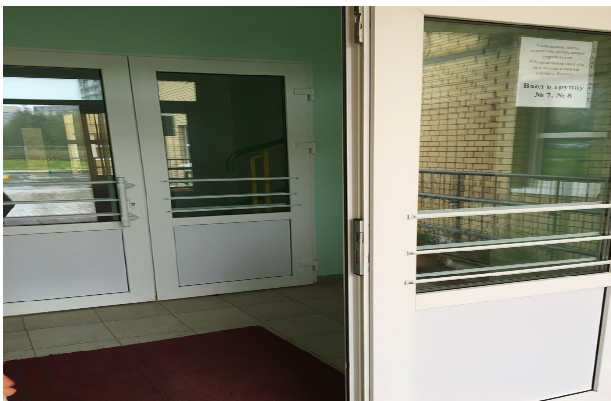
Фото № 13 Вход № 2 (тамбур)
