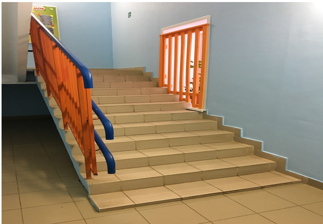
Фото № 37. Лестница № 3 внутри здания
