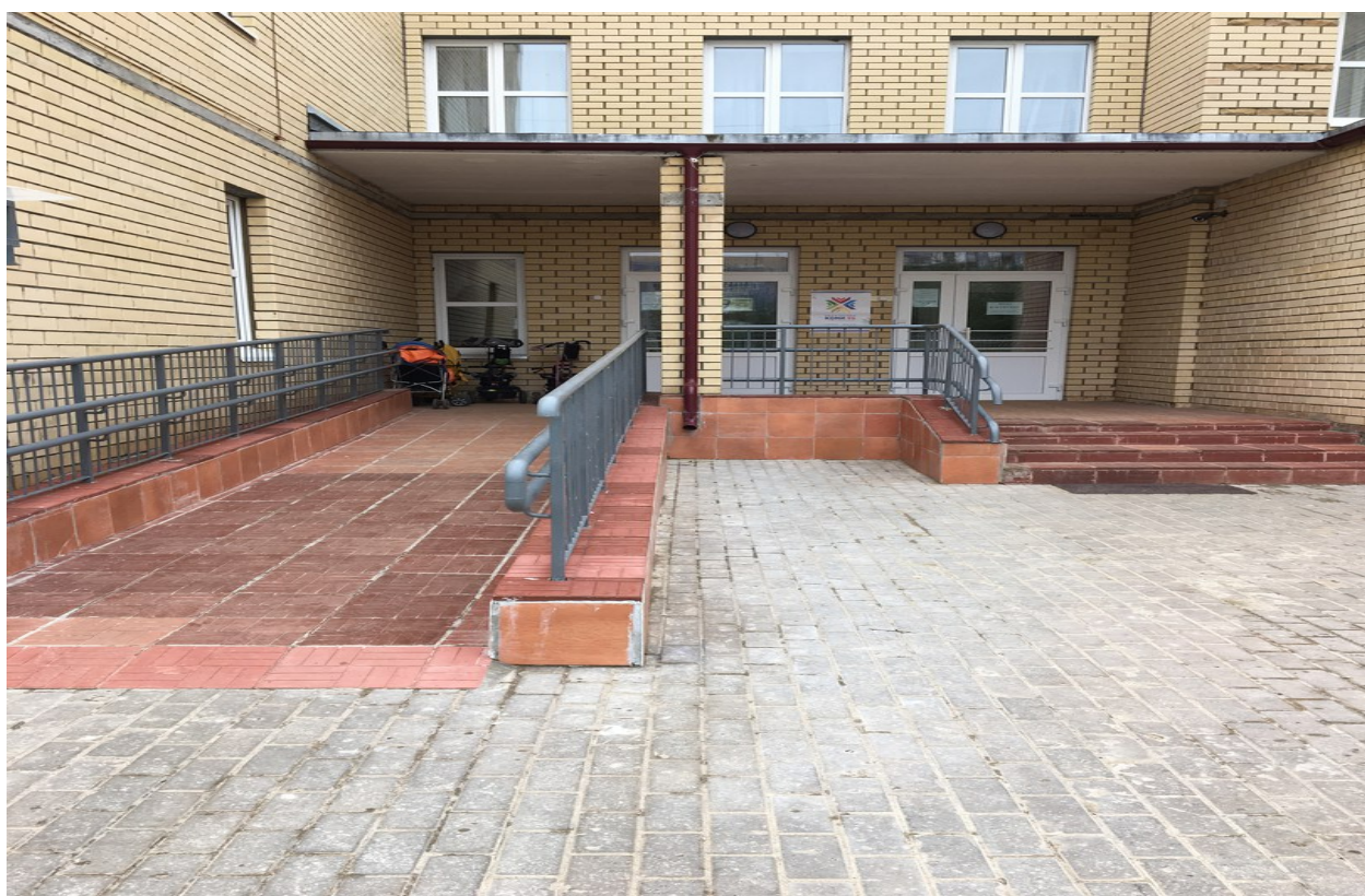
Фото №9 Центральный вход (№1)
