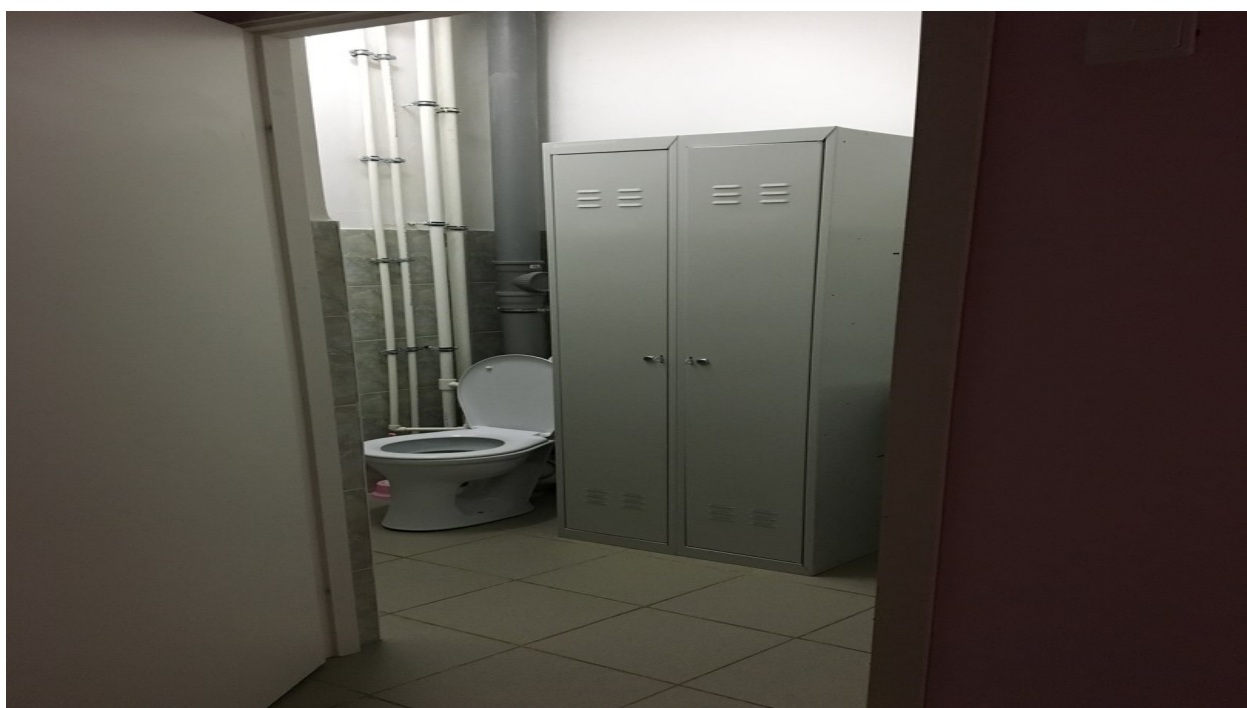
Фото № 48. Санитарно-гигиенические помещения
