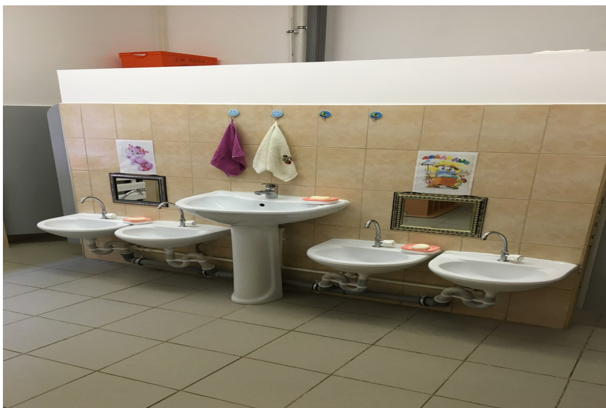
Фото № 50. Санитарно-гигиенические помещения.
