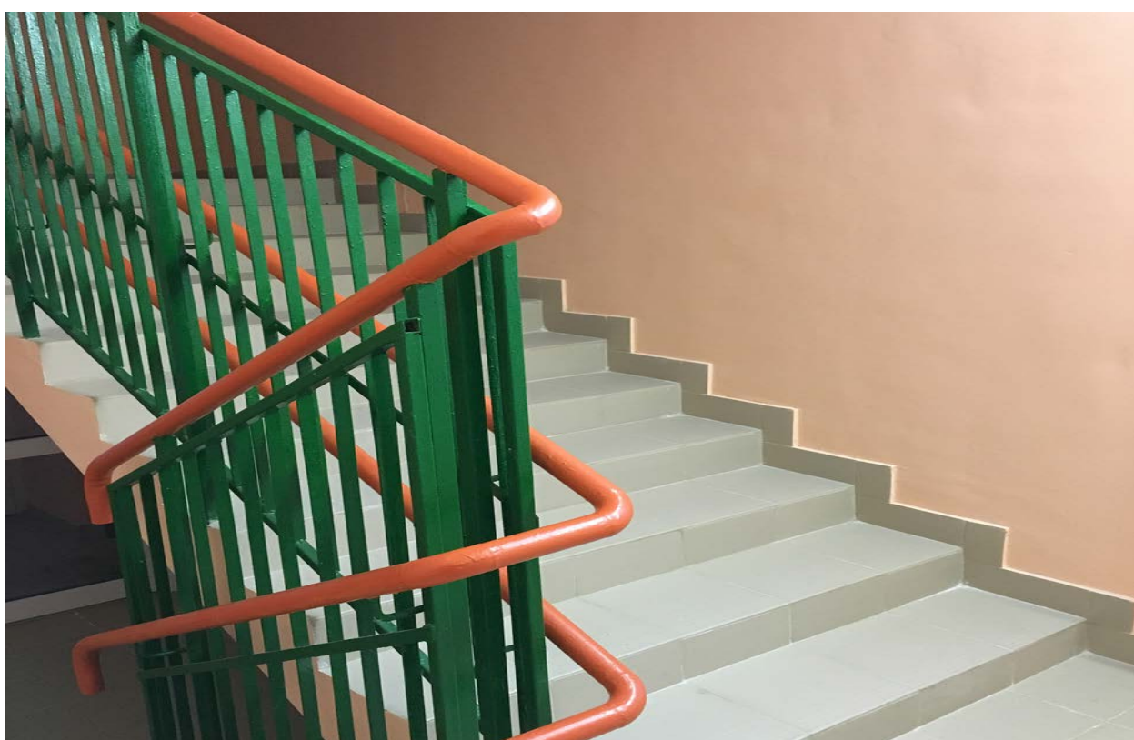
Фото № 38 Лестница № 4 внутри здания
