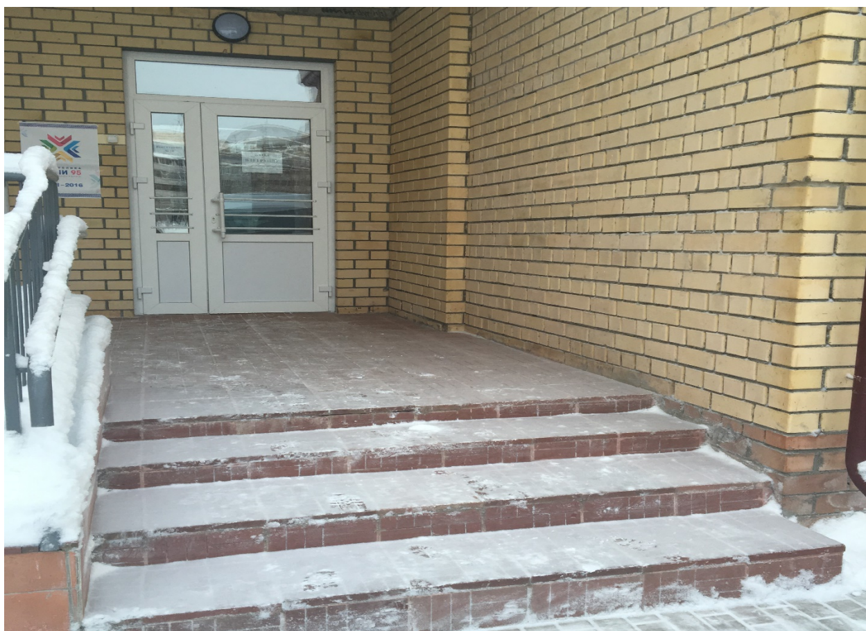
Фото №8 Центральный вход (№1)
