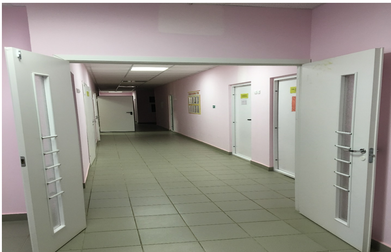
Фото № 30. Коридор пути движения внутри здания
