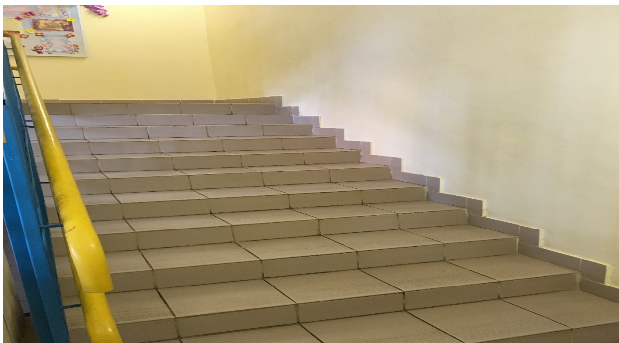
Фото № 33. Лестница внутри здания
